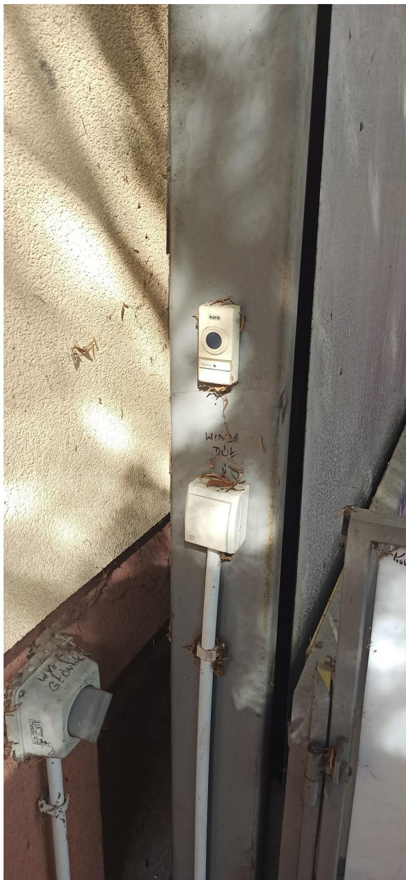
Fotografia 64 Słupek przy windzie dla niepełnosprawnych
