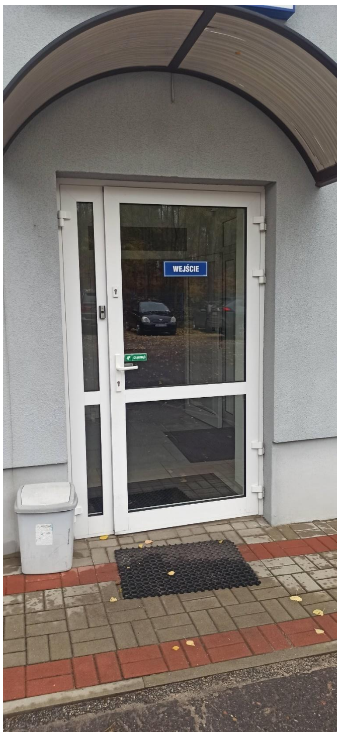
Fotografia 14 Drzwi wejściowe do pomieszczeń biurowych
