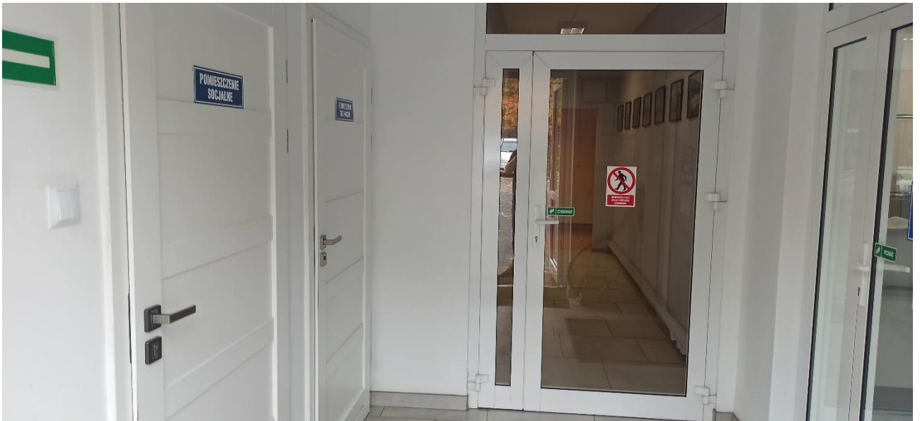
Fotografia 15 Korytarz wejściowy z drzwiami do Pomieszczenia socjalnego, Toalety (pomieszczenie techniczne) oraz dalszej części korytarza
