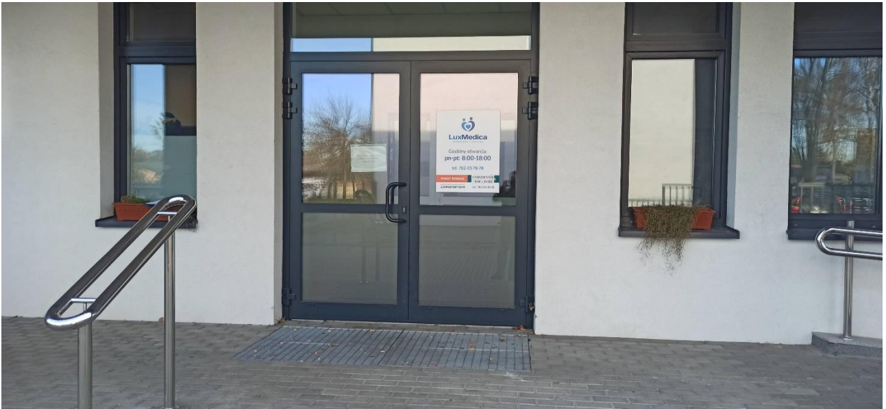
Fotografia 45 Drzwi wejściowe na wprost schodów
