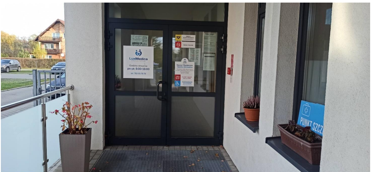
Fotografia 44 Drzwi wejściowe po lewej od schodów
