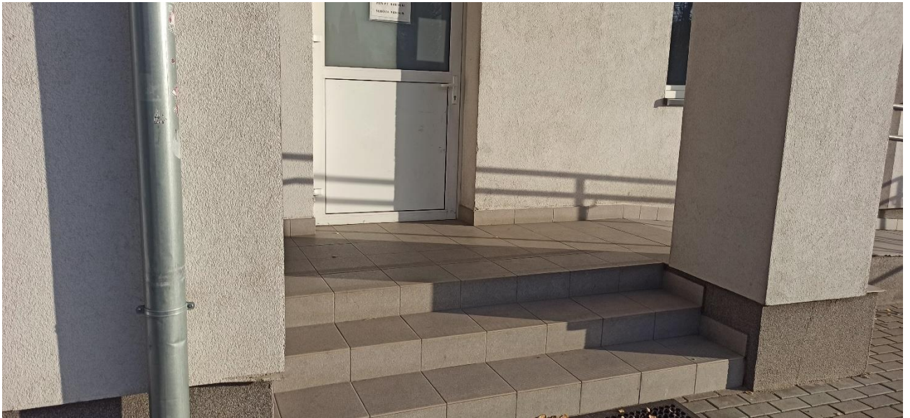
Fotografia 43 Schody wejściowe do starego ośrodka zdrowia, w tle widoczne drzwi wejściowe
