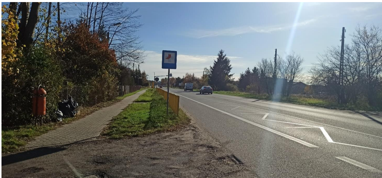
Fotografia 46 Droga Krajowa nr 91 w Słowiku
